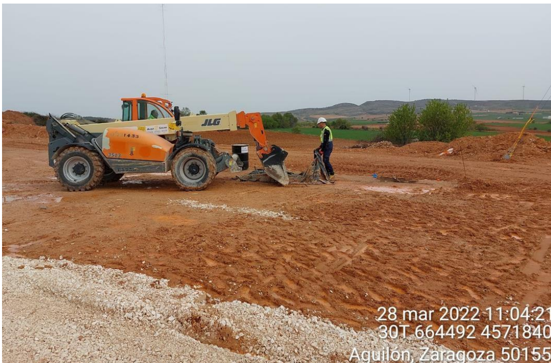
Imagen 4. Máquina recogiendo plástico con restos de residuos de hormigón.
