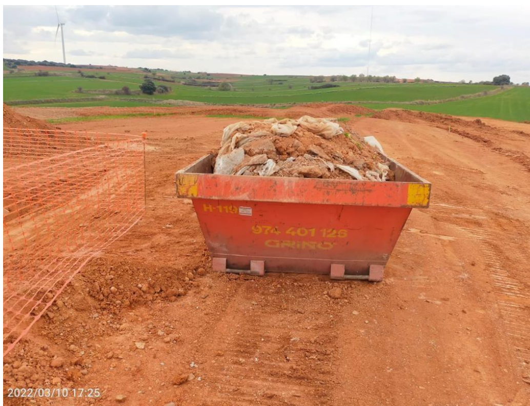
Imagen 3. Contenedores en obra con el residuo de hormigón de las zonas de lavado
